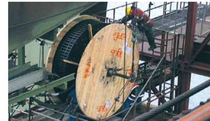
readychain®-Montage unter igus®-Betreuung auf einem Schüttgut-Kran. Das Gewicht der e-kette® einschließlich chainflex® beträgt mehr als 2 t.
