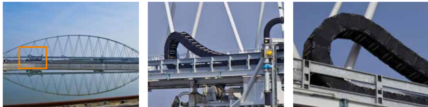
Eine um 360° drehbare Brücke der Schlickaufbereitungsanlage mit zwei großen E4.350 e-ketten®
